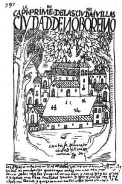
Figura 9 La capital del Nuevo Reino de Granada a finales del siglo XVI
