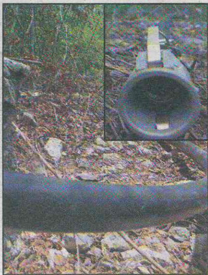
UNA manguera fue localizada hacia el lado derecho del camino a una distancia de aproximadamente 10 metros. Es la tercera toma clandestina que es localizada en los últimos 15 meses.
