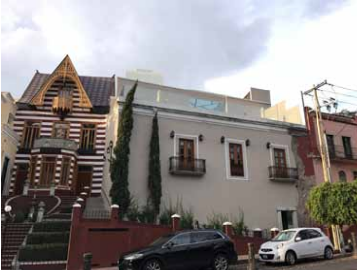
Imagen 4: Modificaciones resultantes, terrazas acristaladas, modificaciones estructurales y ampliaciones
