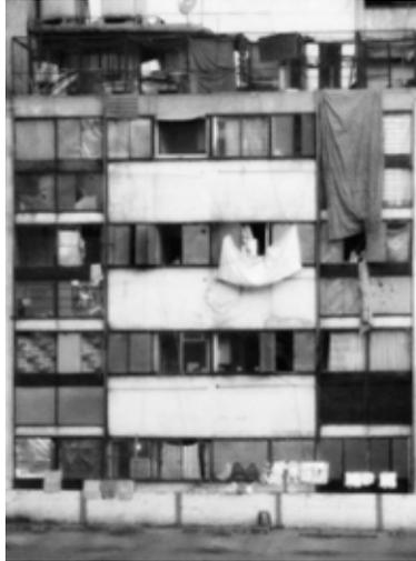
Imagen 71. Edificio en Coatzacoalcos Veracruz. Falta de mantenimiento, acumulación de basura en azotea, grandes ventanales, sin elementos expresivos. (Fotografía: Mauricio Velasco)
