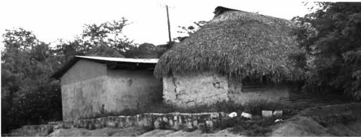
Imagen 116. Bohíos en comunidad rural cercana a Ciudad Valles, SLP. Es evidente el cambio de material y cambio formal de la tradicional vivienda de la Huasteca Potosina. Obsérvese que la primera construcción ya no es un bohío, es una estructura de tabique y aplanados de cemento que sustituye los muros de varas con adobe y aplanado de adobe, coloca cubierta de láminas, que sustituye la cubierta de palma característica. (Fotografía propia)
