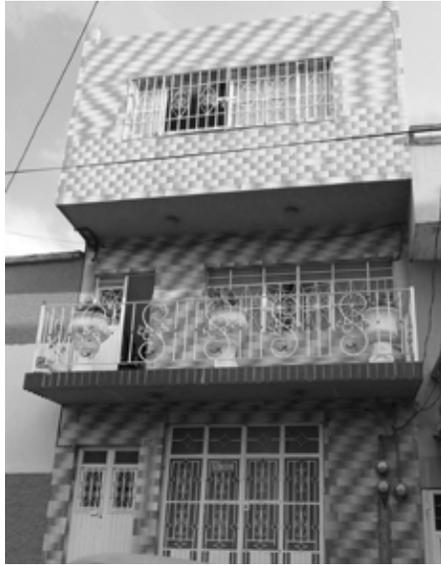
Imagen 67. Sustitución de los acabados exteriores por azulejos en toda la fachada. (Fotografía propia)
