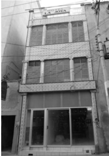
Imagen 74. Centro de San Juan de los Lagos, Jal. Fachada y columnas forradas con azulejos. (Fotografía propia)
